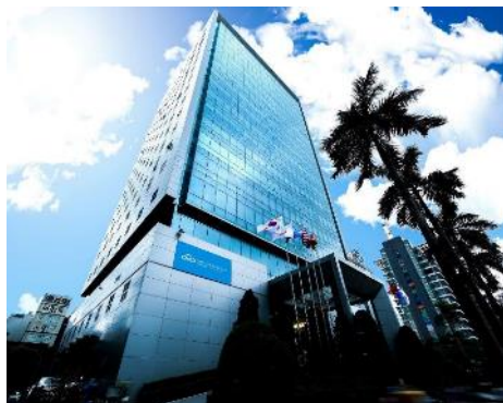
ベトナム本社ビル
