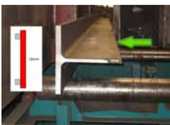
104 Richten nach dem Brennschneiden Straightening after thermal cutting
