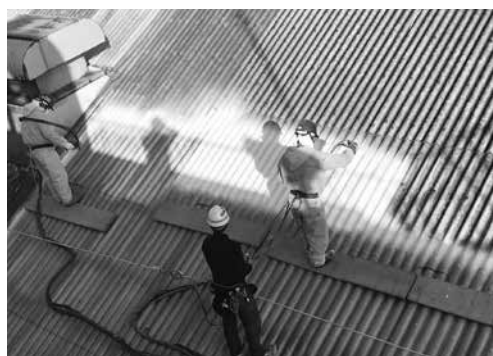
写真3 現場発泡ウレタン断熱材(右)およびスプレーウレタン防水(左)の同時吹付け
