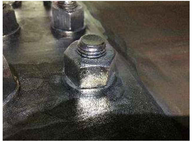
写真-14 添接部 レーザー照射後
