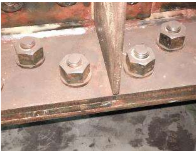
写真-13 添接部 レーザー照射前
