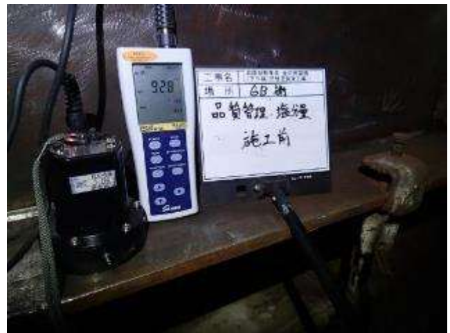
写真-3 剥離剤使用後塩分測定
