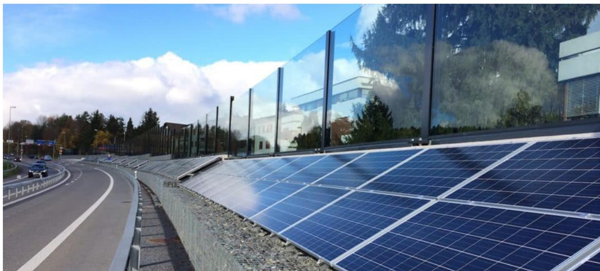
Abbildung 4: 2014 wurde durch das Tiefbauamt des Kantons Zürich an der Forchautobahn auf 300 Metern Lärmschutzwand eine PV-Anlage installiert, Betreiber ist Zürichsee Solarstrom AG (Bild: © Tiefbauamt Baudirektion Kanton Zürich)
