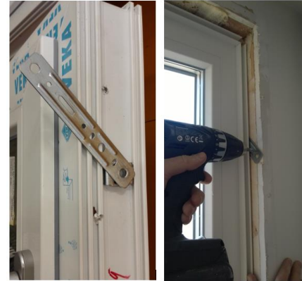
Kuva 1. Kiinnitysraudat ja ikkunan kiinnittäminen
