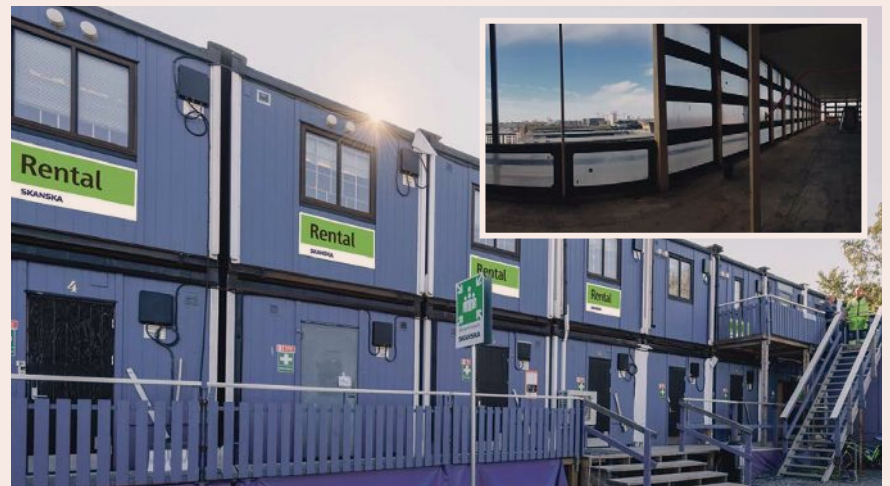
Bodetablering, Skanska Rental. Altiflex (lilla bilden) en effektiv avskärmning av bygget förebygger fuktskador, behåller värmen och reducerar torkningstiden.
