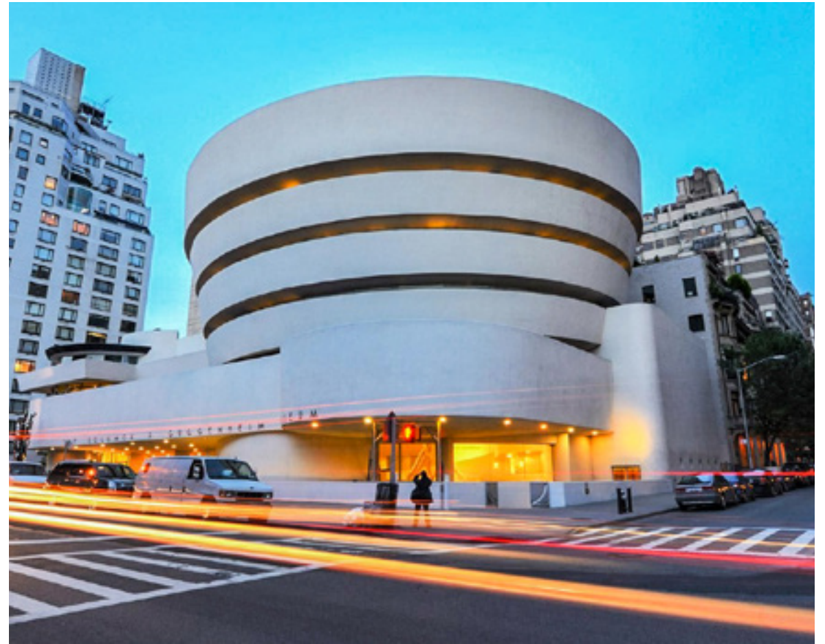
Iluminación Guggenheim Museum Nueva York, EUA
