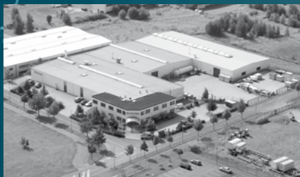
BOSECKER VERTEILERBAU SACHSEN GMBH, ZITTAU
