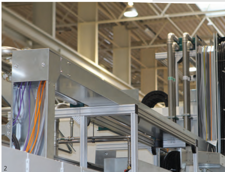
Abb. 1 – Rundum geschützt werden die Kabel im Industrie-Kanal durch die Anlagen geführt. Fig. 1 – Protected on all sides, the cables are routed through the plant in Industrial-Trunking.
