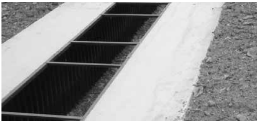
写真-16 耐酸性を確保した水路工
