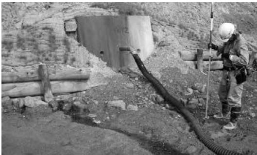
写真-7 ボーリング暗渠工の吐口
