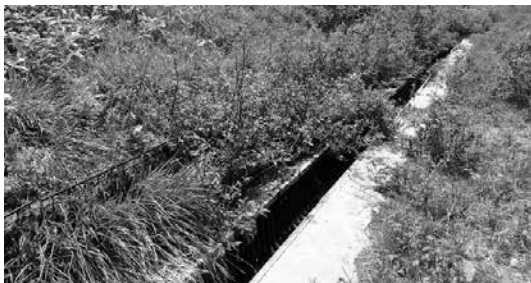
写真-37 かご土留工の周辺での緑化の現状
