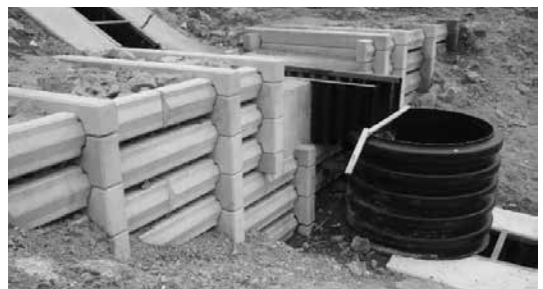
写真-15 耐酸性を確保した土留工
