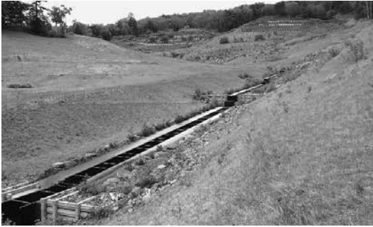
写真-23 裸地斜面における現在の復旧状況
