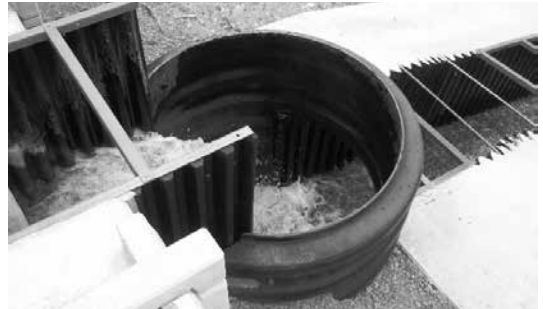
写真-17 耐酸性を確保した集水桝
