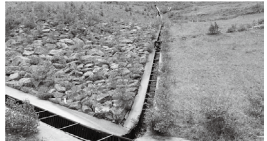
写真-35 自然石張り緑化と緑化マットの緑化比較
