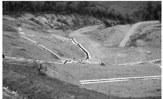
写真-18 耐酸性を確保した構造物の施工状況
