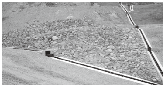
写真-22 酸性水が湧出する斜面への自然石張り
