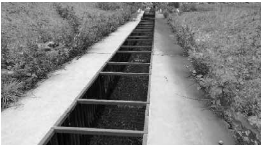
写真-25 耐酸性を確保した水路工の現状
