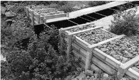
写真-24 耐酸性を確保した土留工の現状
