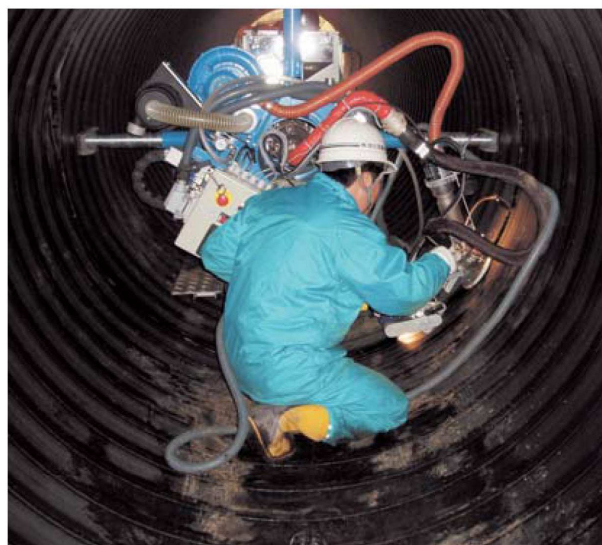
ウェルディング継手施工状況
