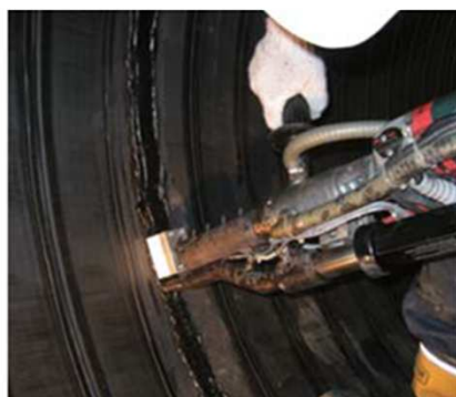
②ウェルディング継手施工
