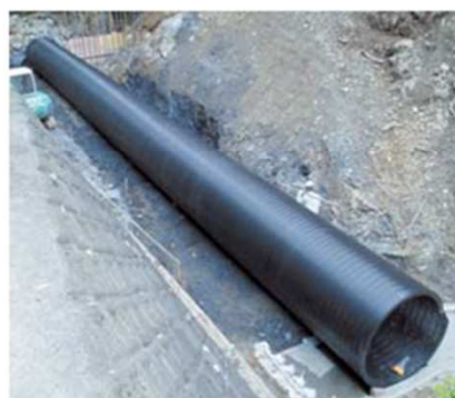
③据付け完了
