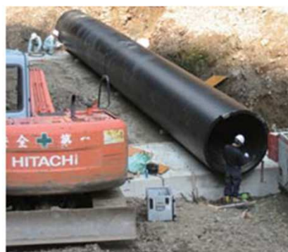
③据付け完了
