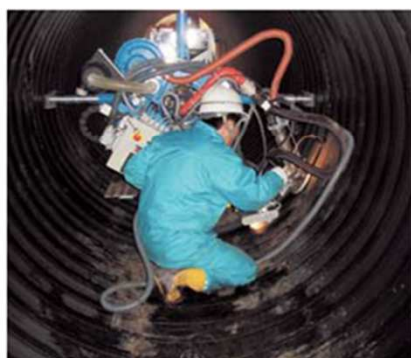
②ウェルディング継手施工
