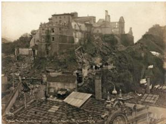
Demolição do Morro do Castelo. No alto do morro, as ruínas da Igreja de São Sebastião.
