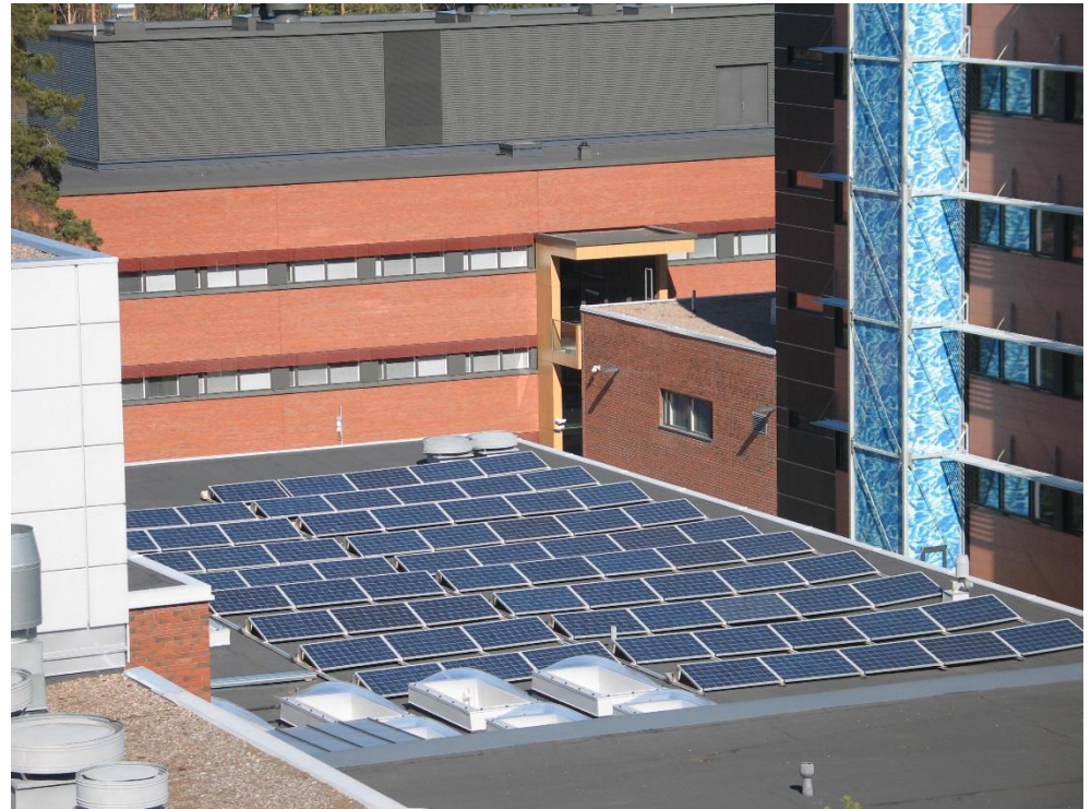
Kuva 51.5 kW:n voimala tasakatolla 9.4.2014.
