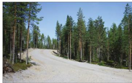
Tuulivoimastoja tarvitsee hyvät tiet alueella. 30 tonnin akselipainon kestävien teiden täytyy olla vähintään 5,5 metriä leveitä ja aina käyttökuunnossa. Teiden ylläpidosta huolehtii tuulivoimayhtiö ja tiet ovat yleensä käytössä.
