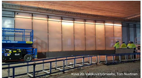
Kuva 20. Valokuva työmaalta, Tom Nuutinen
