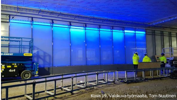
Kuva 19. Valokuva työmaalta, Tom Nuutinen
